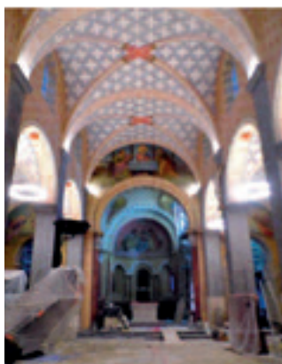
Nef fin des travaux
